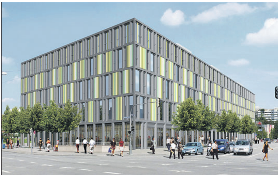
Auf jeweils 2.500 Quadratmetern im dritten und vierten Obergeschoss haben Ärzte, Apotheker, Kliniken und andere die Möglichkeit, ihre Räume zu gestalten.
